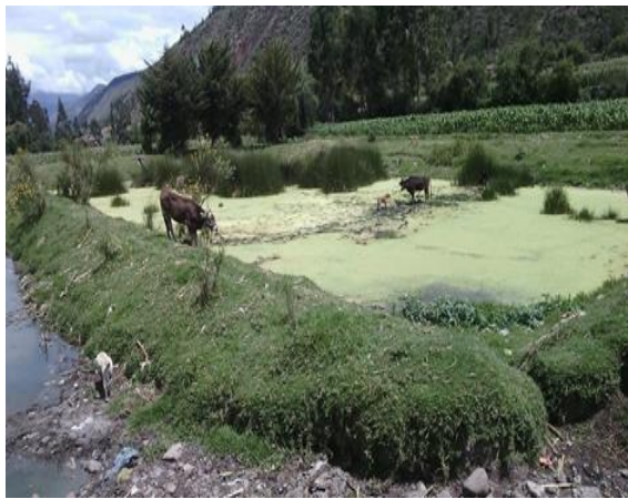
Figura 2. Laguna de oxidación inactiva
