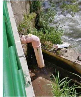
Figuras 07 y 08. Colector aéreo a orillas del río Chuyapi en Quillabamba; sus aguas son vertidas directamente en el río.
