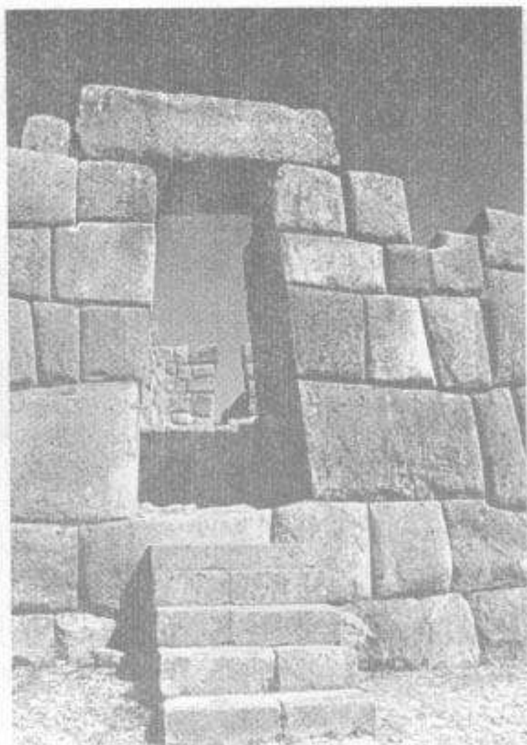
Portada al sol con dintel original, las cinco gradax colocadas por Valedúcel. (Deben ser retiradas).
