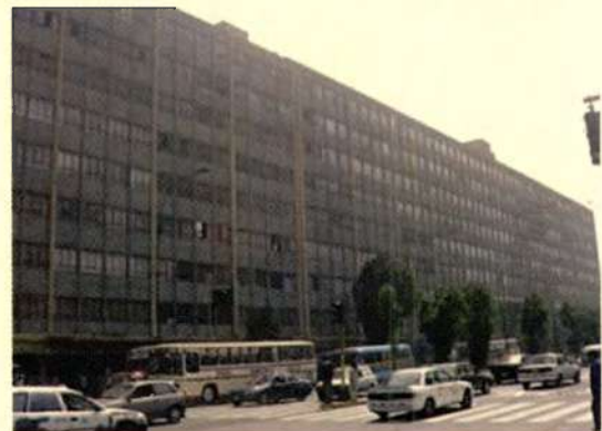
Edificios abandonados en el Centro de Lima.
