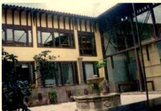
Edificio SUNAT. Cusco.
